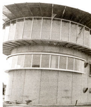
La Centrale di comando a Collegno
